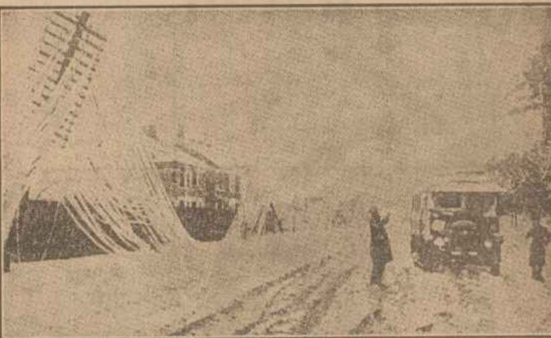
Zăpada de aproape 4 metri, căzută în timpul unui viscol, a izolat complet unele districte, a rupt firele de telegraf și telefon și a blocat drumurile
