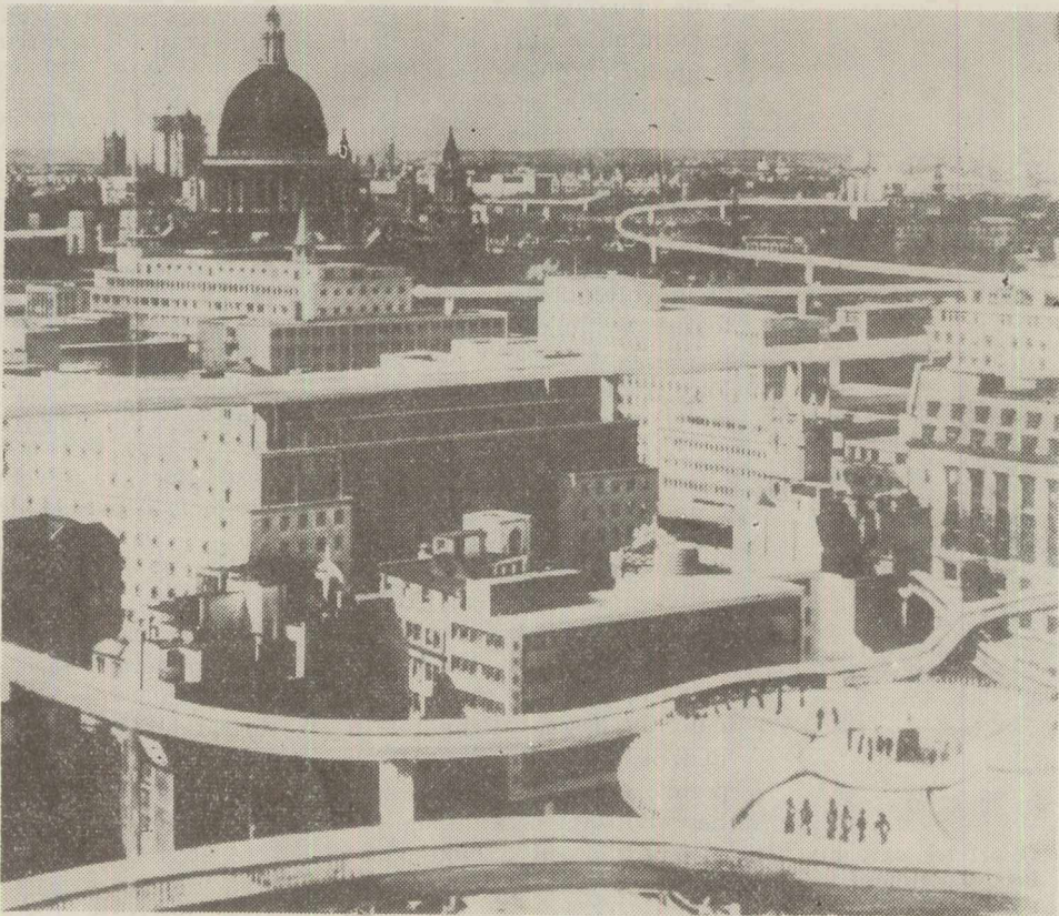
● Schiță a unei soluții propuse pentru rezolvarea problemei traficului într-un mare oraș. E vorba de un sistem de transport la înălțime, avînd stații la circa 400 metri distanță una de alta.
