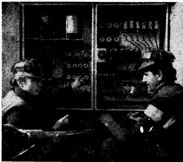
Electricienii Ion Todea și Ioan Hamz, verifică pupitrul electric al unei foreze în cariera Cimpului Neag.
