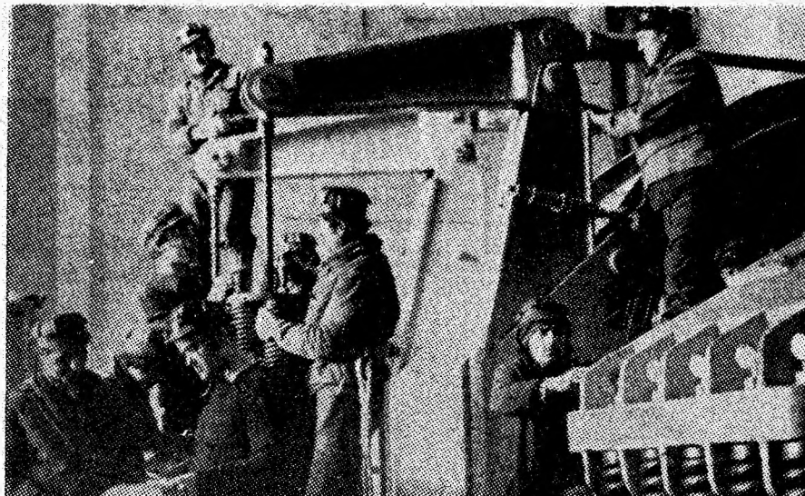
Echipele de lăcătuși și electricieni de la lotul Petrila al I.C.C.M.O., conduse de Petre Gică și Aurel Ghiban, împreună cu maistrul mecanic Gheorghe Dumitrașcu, fac ultimele verificări după prima încercare la probele în sarcină a mașinii de extracție la noul puț cu schip de la mina Petrila.
