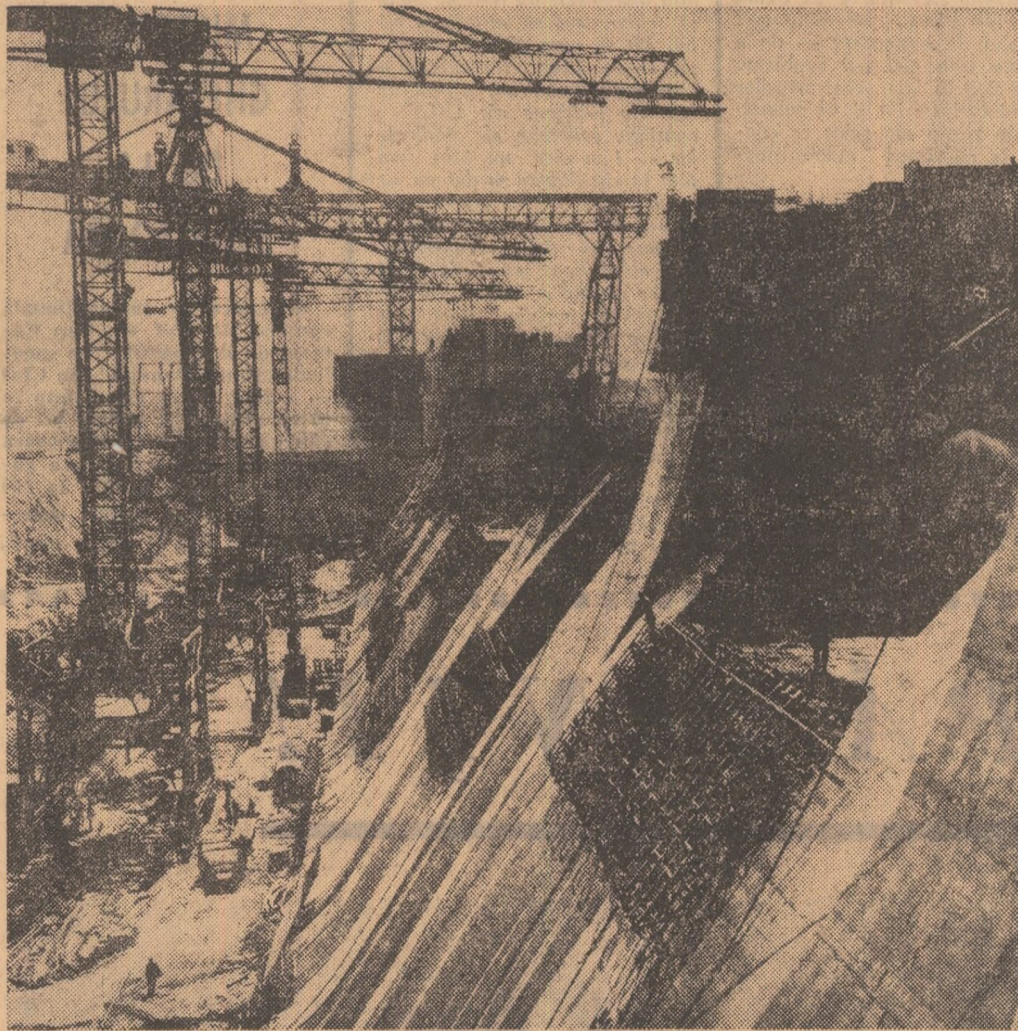
Barajul de la Porțile de Fier.
