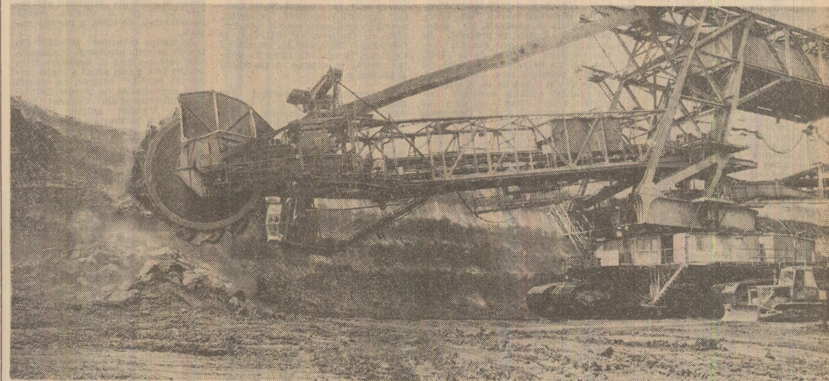
Utilaje de mare randament, asemenea excavatorului 1300-03 de la cariera Tismana I, din bazinul minier Rovinari (în fotografie) continuă zi de zi marea bătălie pentru a asigura țării cărbune cît mai mult și de calitate. În pagina a IV-a a ziarului: SECVENȚE DIN MUNCA MINIERILOR DE LA ROVINARI Foto: Eugen Dîlbășanu
