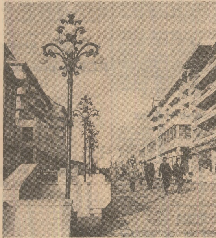
Construcții de locuințe moderne, frumoase în municipiul Suceava
