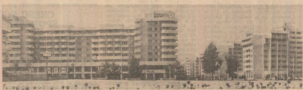
Noi construcții de locuințe la Brăila
