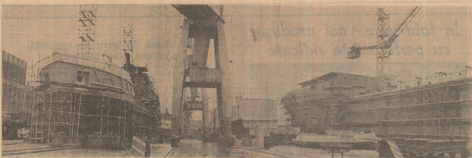
Imagine de pe Șantierul naval Drobeta-Turnu Severin
