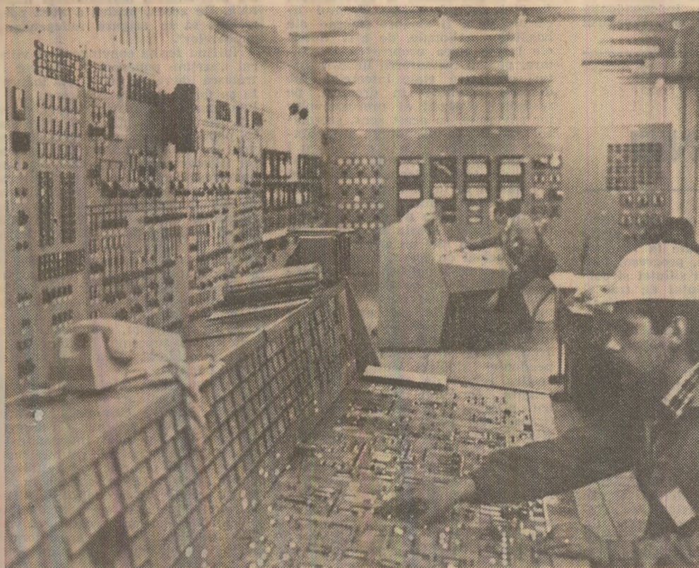
Pe energeticienii li stim meru la datorie. Zi de zi, ceas de ceas, ei veghează ca puternicele agregate să pulseze energie electrică în sistemul energetic național. În imagine: aspect de muncă din camera de comandă a termocentralei Drobeta-Turnu Severin
