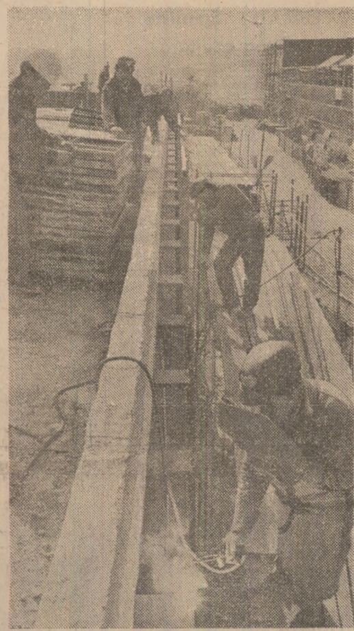
leri, pe șantierul unor noi capacități de producție, la întreprinderea „Sămăntătoarea” din Capitală. Foto: E. Dichiseanu
