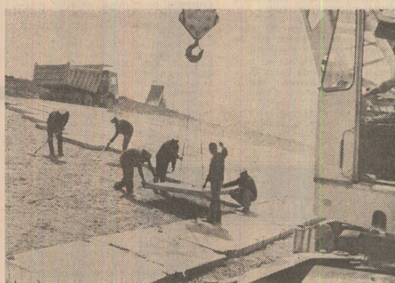
Șantierul național al tineretului „Amenajarea complexă a râului Dimbovită“. Brigadierii acestui șantier merită toate felicitările. Ei și-au realizat planul semestrial în proporție de 181 la sută
