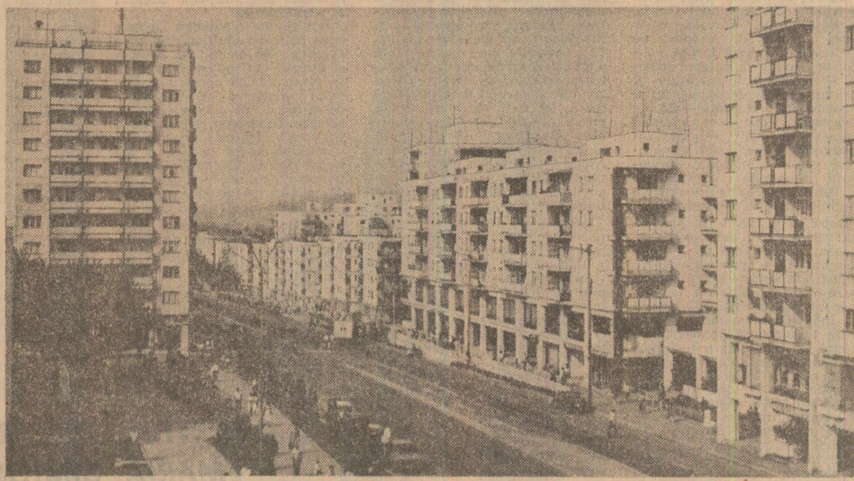
Din noile construcții ale municipiului Vaslui
