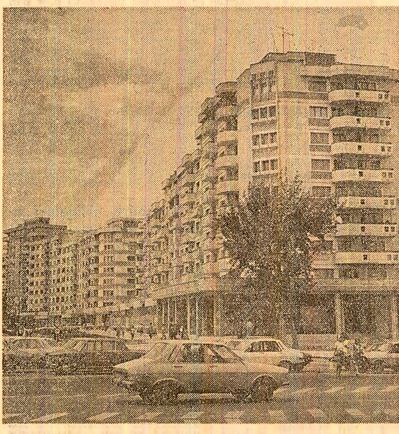
Unul din domeniile cele mai largi și mai rodnice de colaborare între consiliile populare și cetățeni îl constituie pregătirea și realizarea noii infrastructuri a localităților patriei. În imagine — o zonă din noua arhitectură a municipiului Pitești. Foto: S. Cristian
