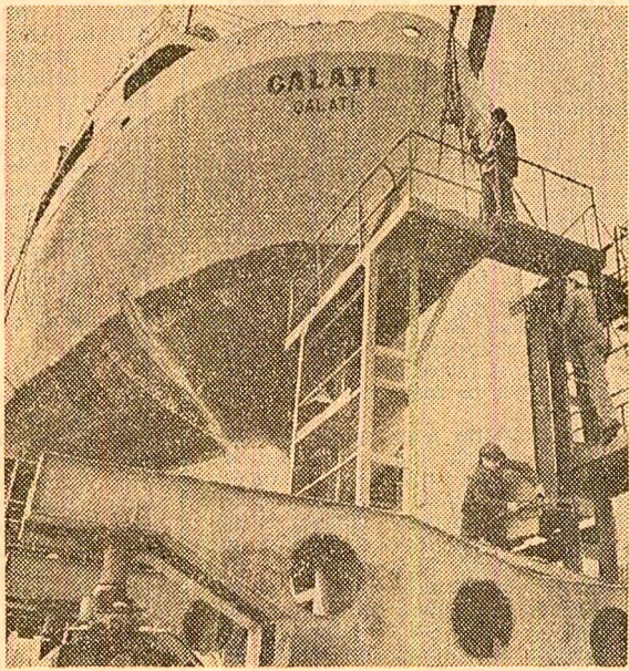
Noi nave în construcție la șantierul naval din Brăila Foto: E. Dichiseanu
