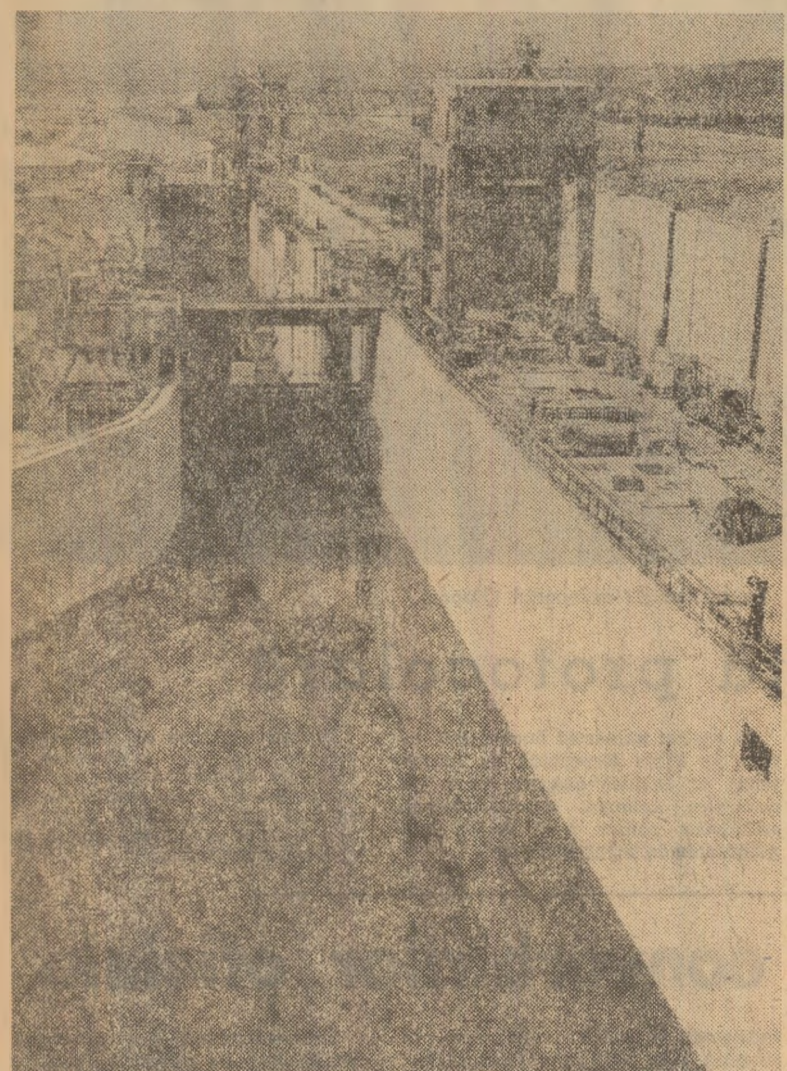
După finalizarea lucrărilor de închidere a Dunării, faza a II-a — un succes de prestigiu al constructorilor de pe șantierul hidrocentralei Porțile de Fier II — în curând se va deschide navigația prin ecluza românească (în fotografie)
