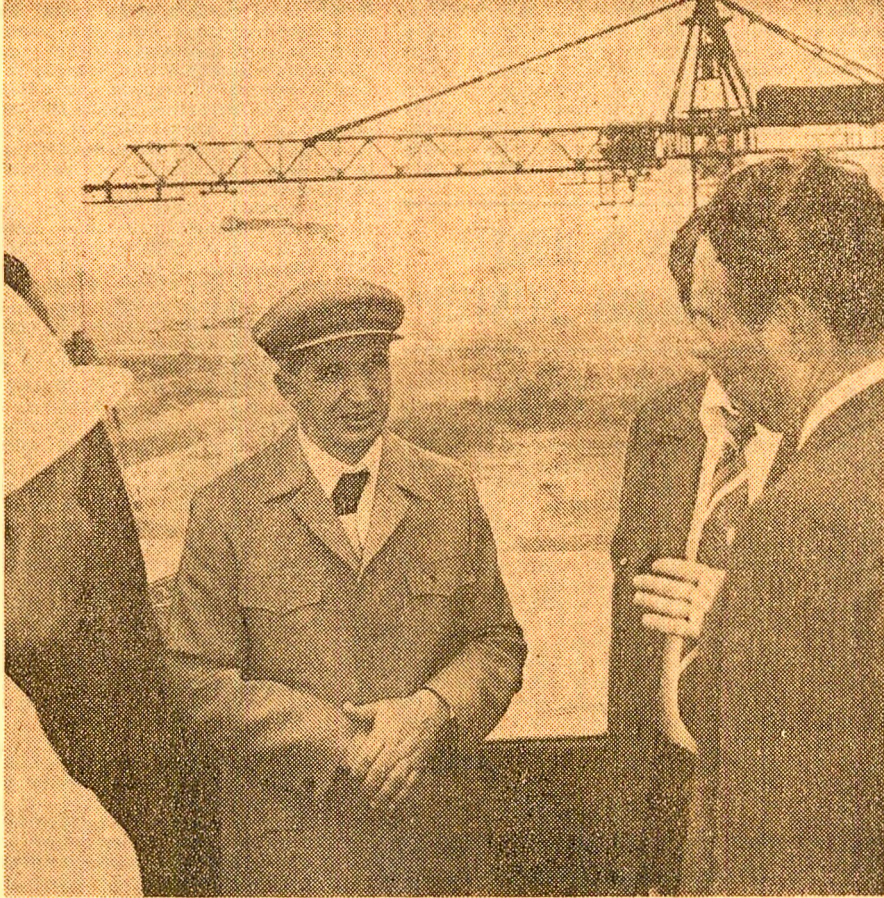
3 Iulie 1981 : Un moment memorabil pentru constructorii Sistemului hidroenergetic și de navigație Porțile de Fier II: tovarășul Nicolae Ceaușescu examinează stadiul lucrărilor pe acest mare șantier hidroenergetic.
