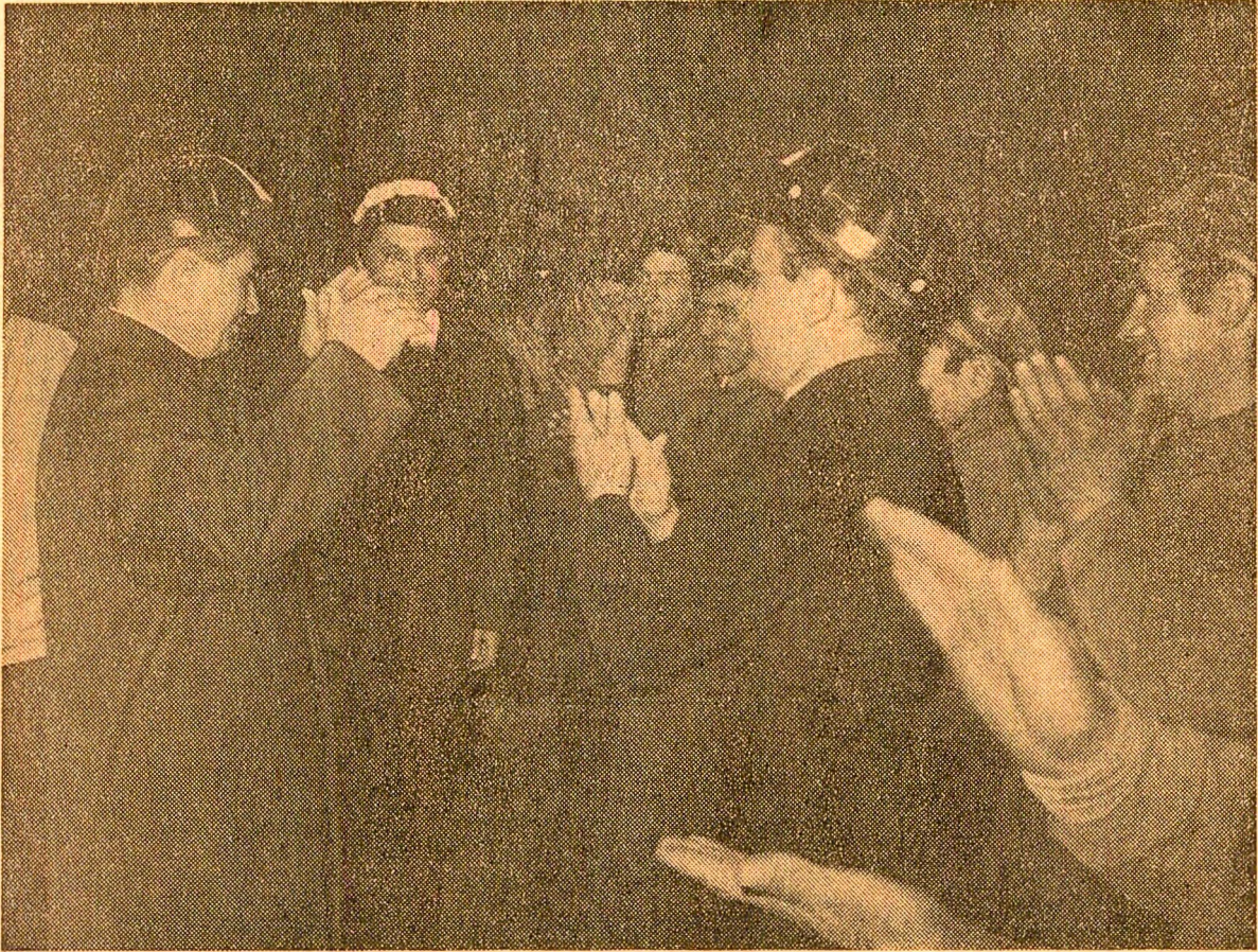
3 Iunie 1972 : Eveniment de seamă pe șantierul hidrocentralei de pe Lotru : în dialog cu constructorii, tovarășul Nicolae Ceaușescu analizează îndeaproape ritmul de lucru la cea mai mare hidrocentrală de pe apele interioare ale țării.
