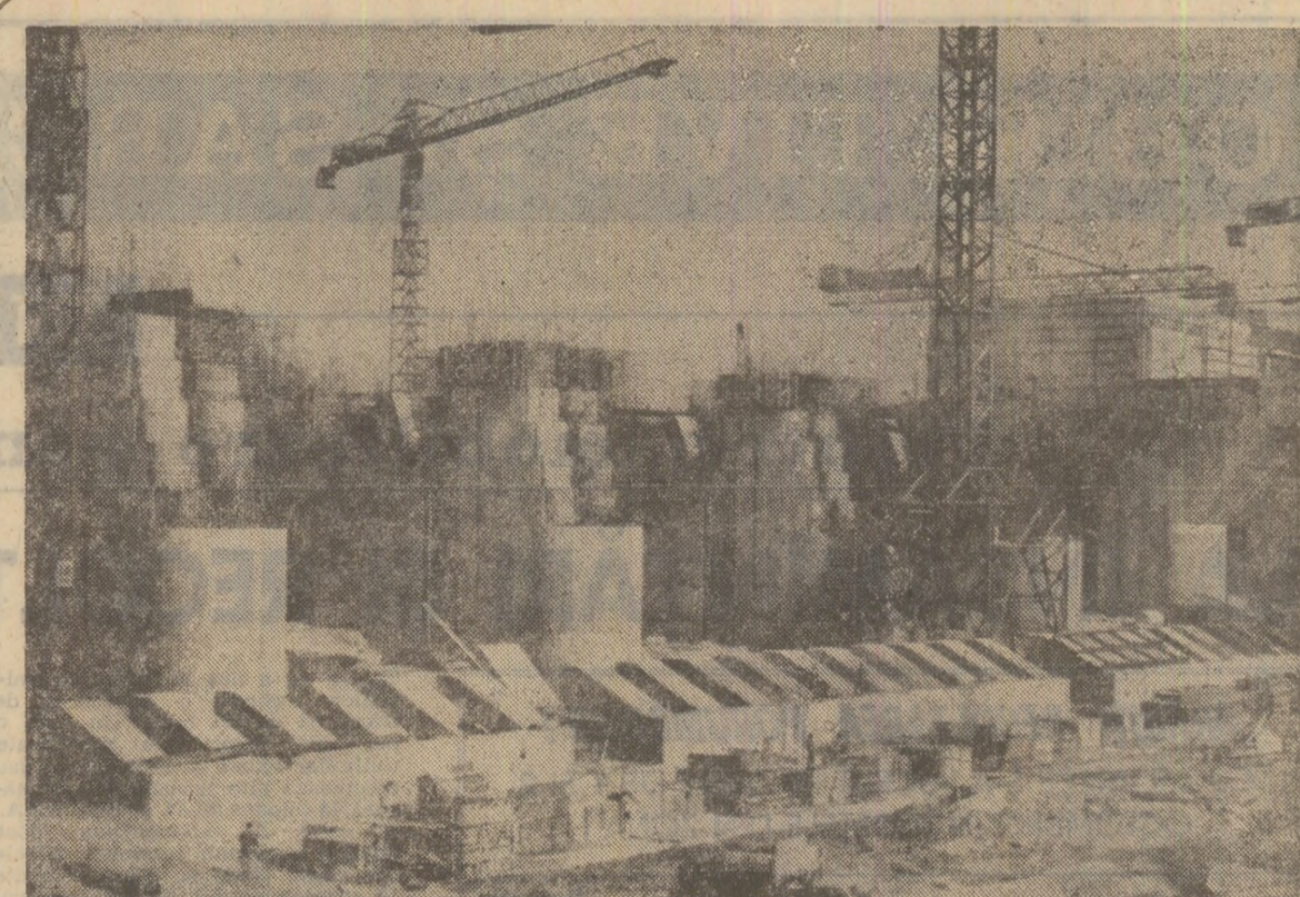
Imagine de pe Șantierul hidrocentralei Porțile de Fier II
