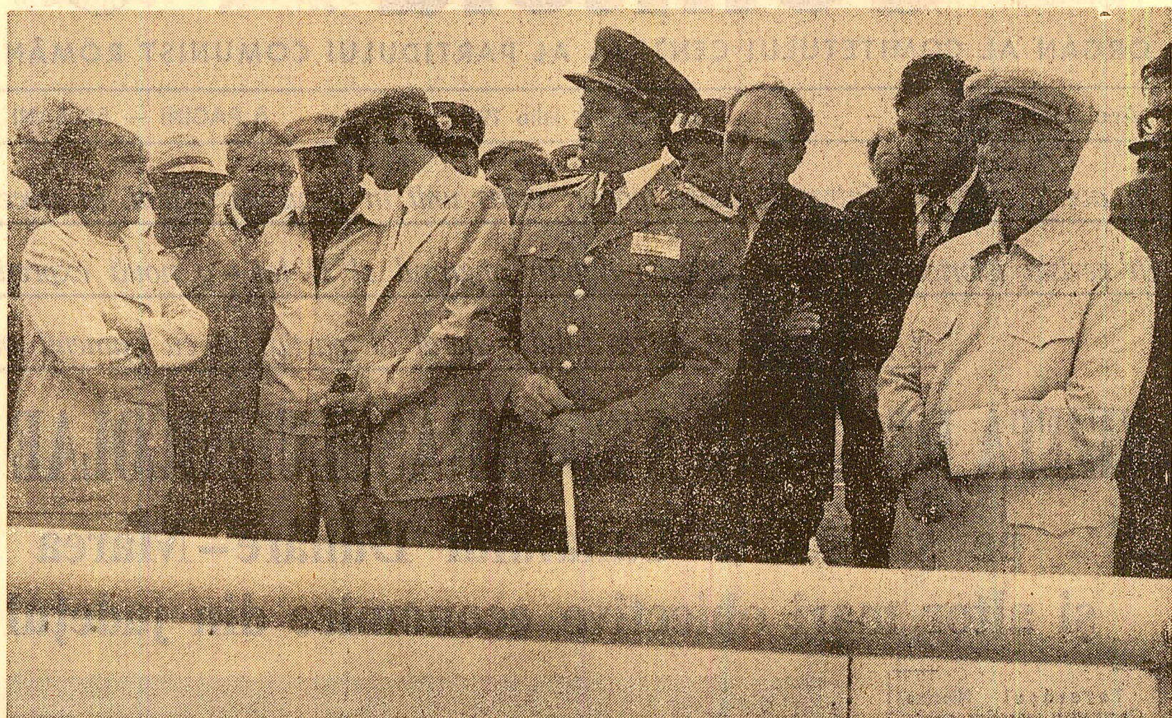
La km 58, zonă în care se execută un mare volum de lucrări
