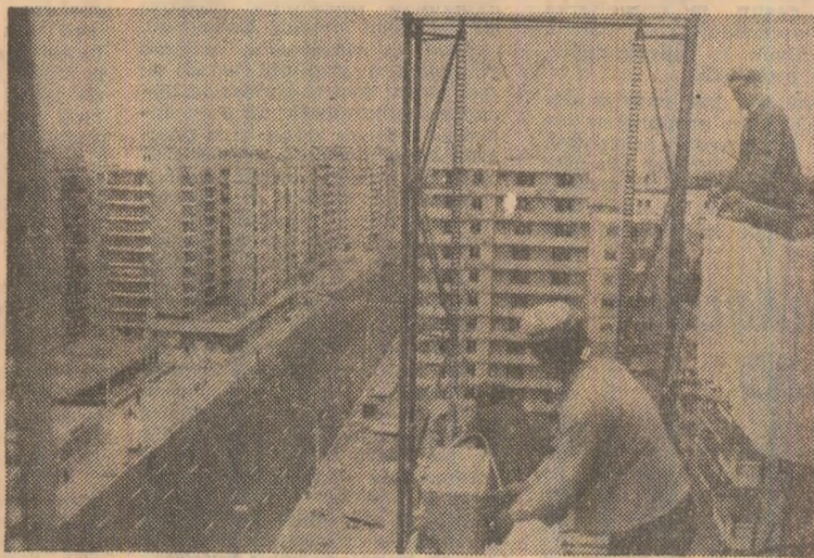
Calea Unirii — magistrală modernă a unui oraș în plină dezvoltare
