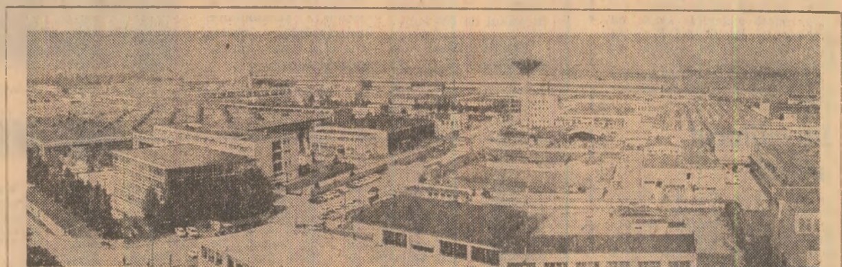
Din noul peisaj economic al patriei: platforma industrială a municipiului Focșani
