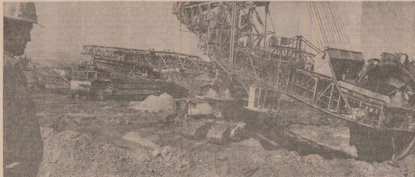
În aceste zile, minerii din bazinul Gorjului acționează ferm pentru sporirea substanțială a extracției de cărbune. În imagine: mijloacele mecanizate sînt utilizate cu înalt randament la cariera Gîrla. Foto: E. Dichiseanu
