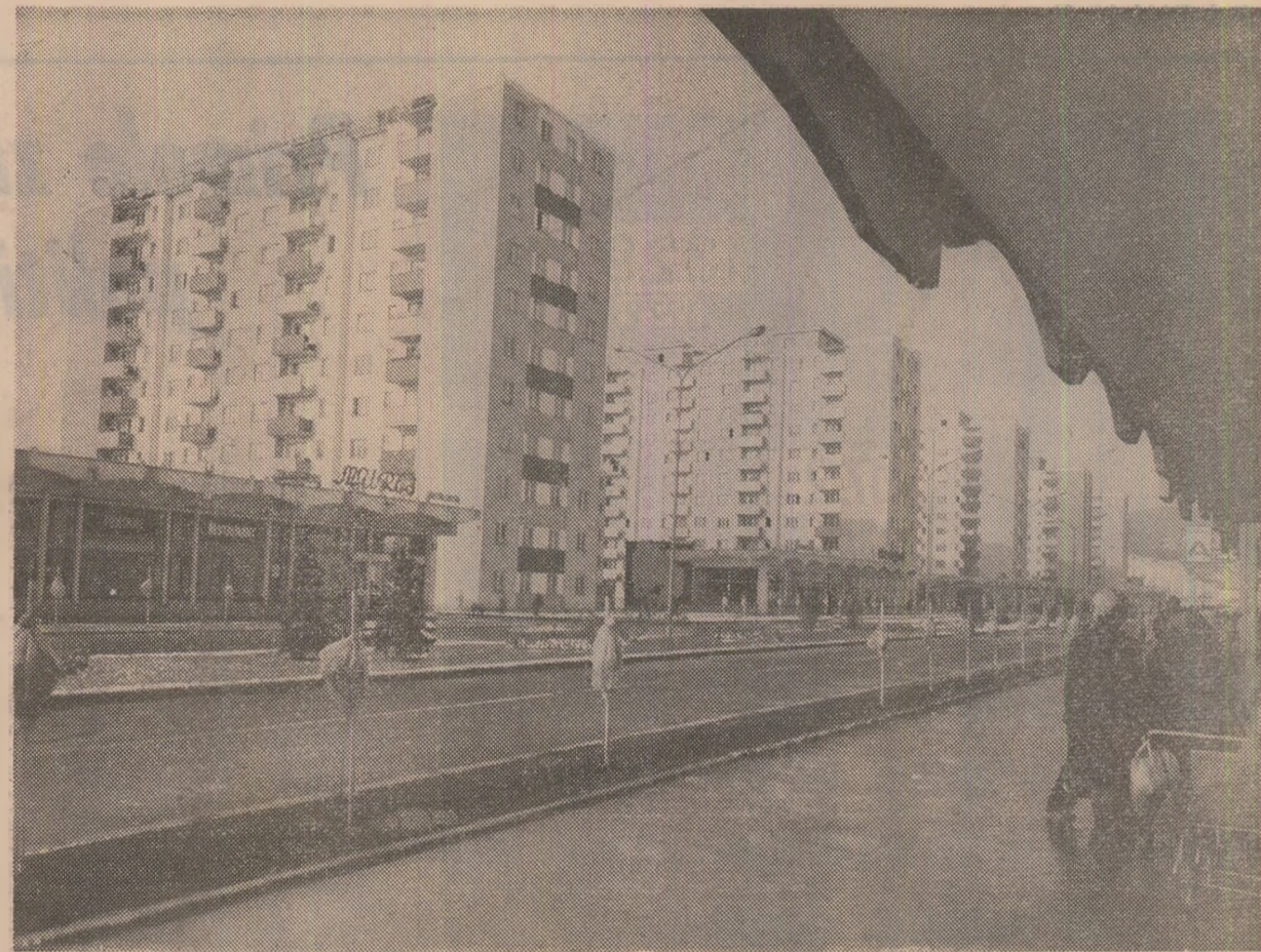
ALBA IULIA. Pe locuințe în care, cu 61 de ani în urmă, mulțimea au salutat „Unirea cea Mare”, astăzi se înalță un nou și modern cartier de locuințe
