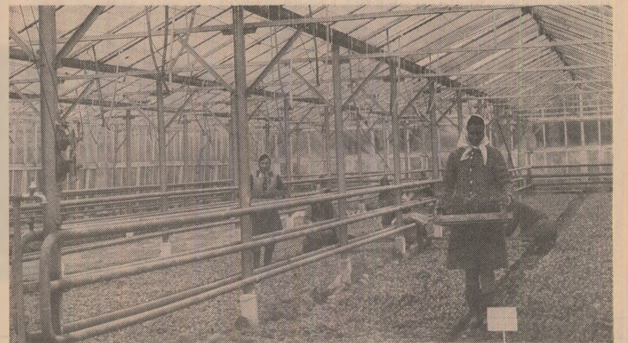
La complexul de sere Topoloveni-Argeș se fac pregătiri în vederea viitoarei producții de legume
