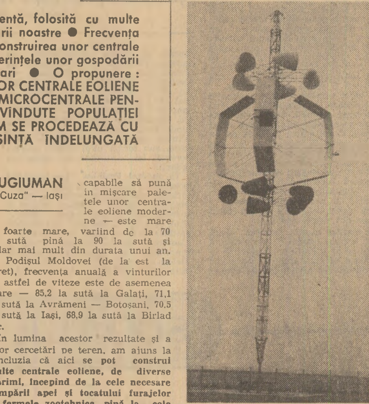
Turbina eoliană — acționată pe baza vîntului — realizată de specialiștii de la INCREST, filiala Brașov. Două in- stalații de acest fel funcționează — pe platforma experimentală — la Mănești (pentru a produce energie electrică) și în Delta Dunării la Sfin- tu Gheorghe (pentru pomparea apei)
