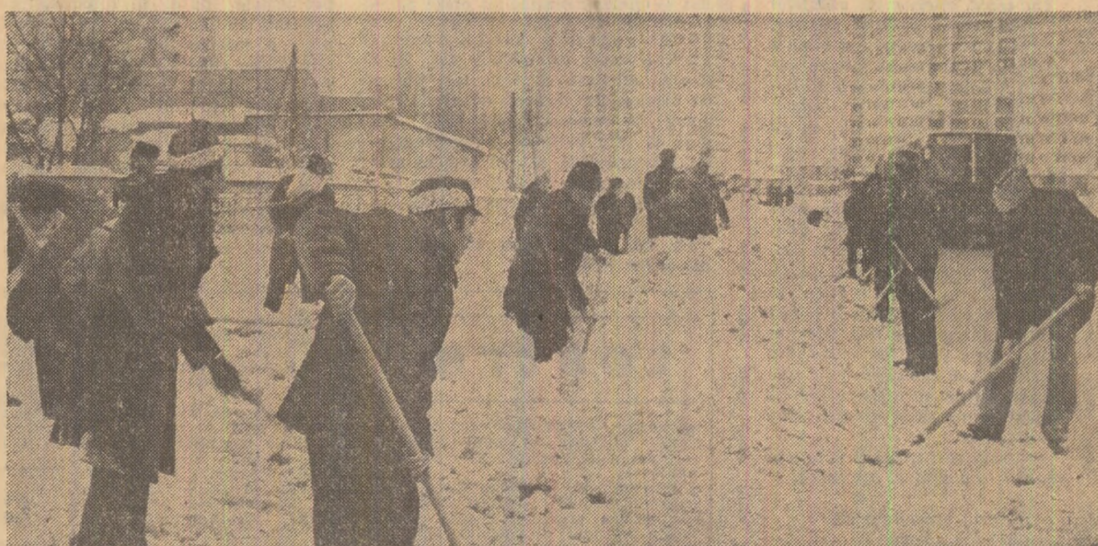
Duminică, în cartierul bucureștean Balta Albă: la intersecția bulevardului Ion Șulea cu strada Drăstor, cetățenii lărgesc partea carosabilă pentru a înlesni circulația mijloacelor de transport în comun
