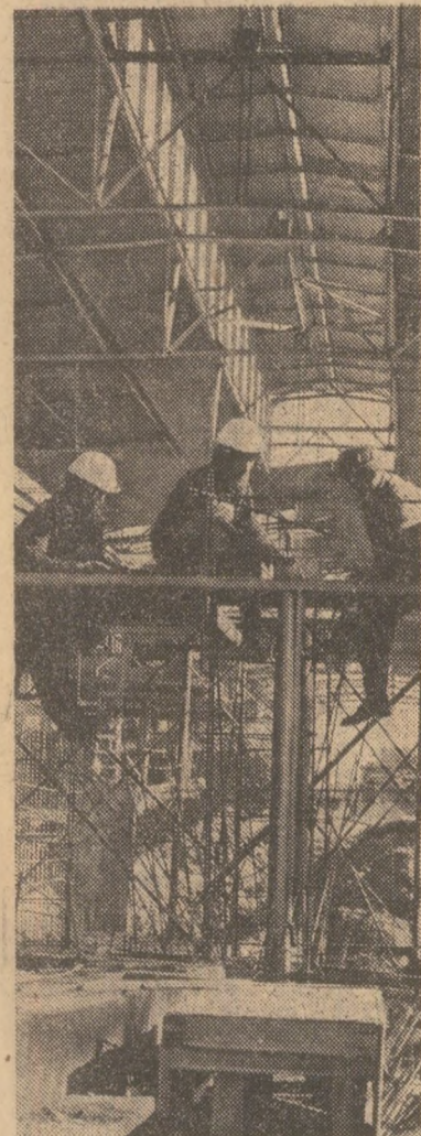
1979 va marca intrarea în funcțiune a primelor capacități cu profil metalurgic la Combinatul siderurgic de la Căldărași. Din primele zile ale anului, constructorii și montorii depun eforturi susținute pentru a apropia momentul inaugural
