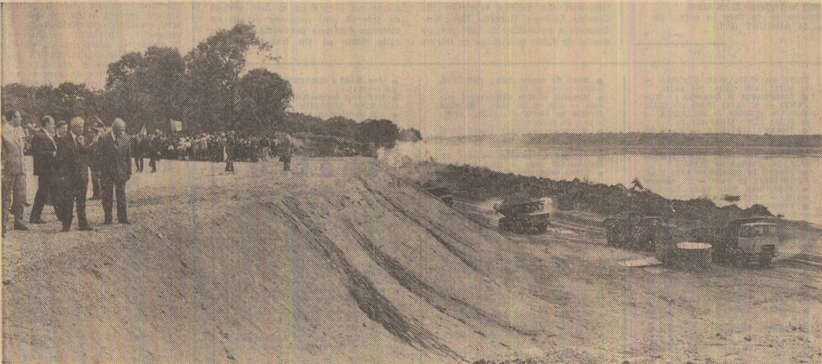
Pe șantierul hidrocentralei „Porțile de Fier II”
