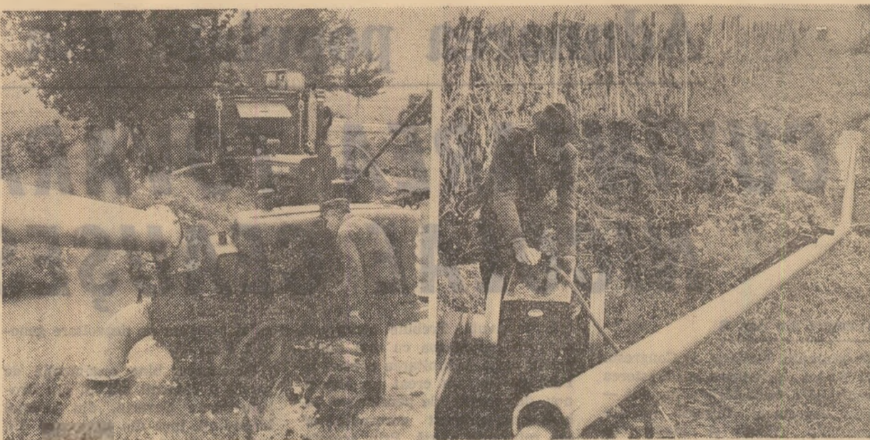
Toate sursele de apă — folosite la irigarea culturilor. La cooperativa agricolă Găvănești, județul Buzău, apa adusă pe un șanț este trimisă cu ajutorul motopompelor pe canalele de irigații (prima fotografie). Uadarea culturilor cu apă din pinza freatică la cooperativa agricolă „Sabarul”-Ilfov (fotografia a doua)
