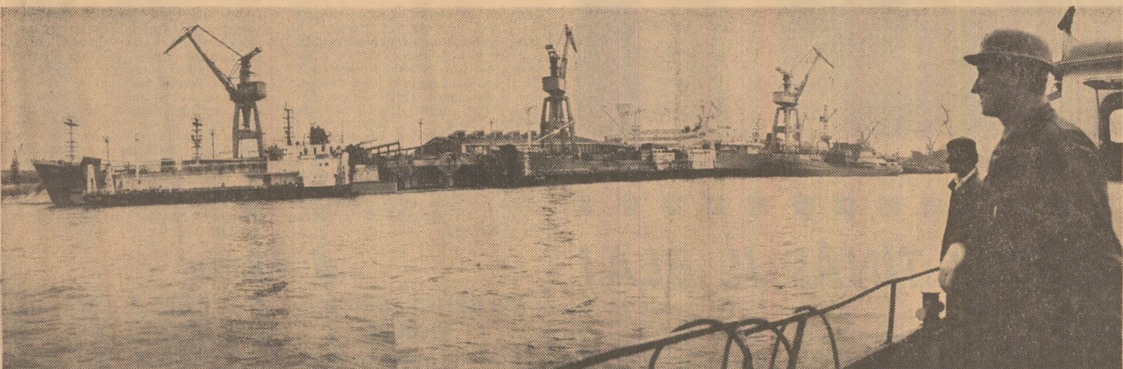
Un nou lot de nave la cheul Șantierului naval din Drobeta-Turnu Severin
