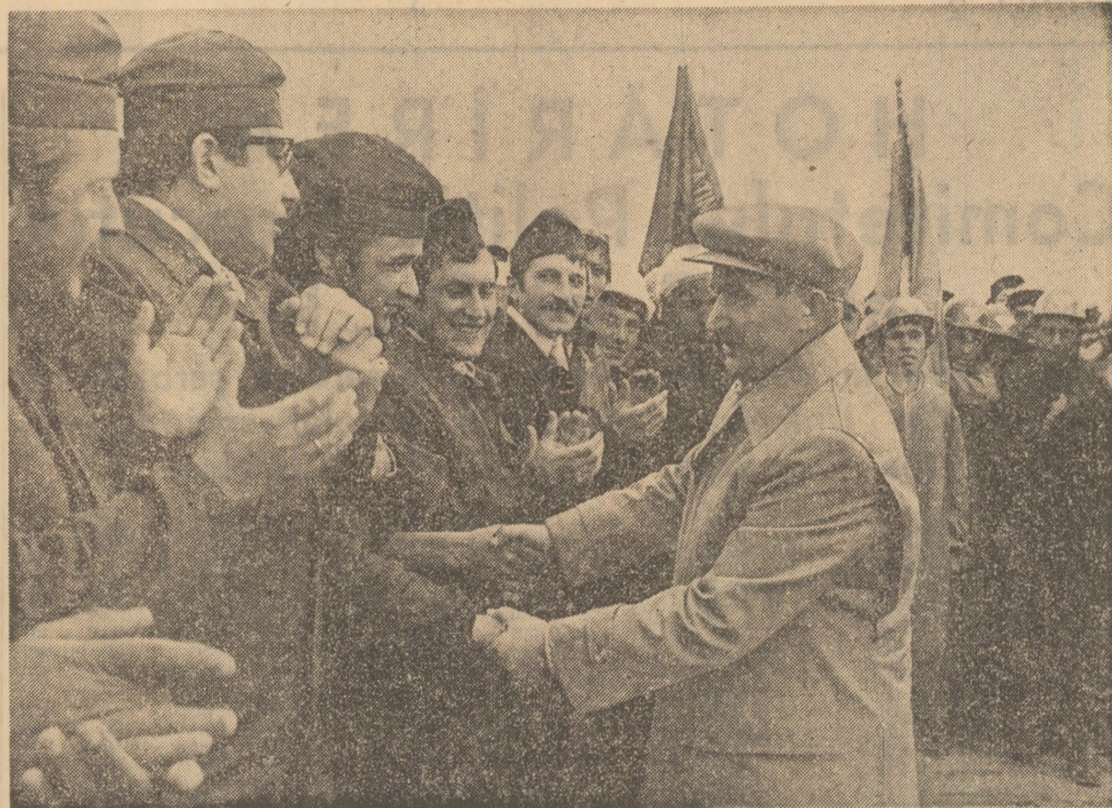
Primire entuziastă, plină de dragoste și stimă, pe șantierul tineretului
