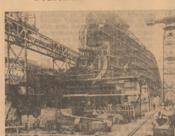
Pe Șantierul naval din Gdansk
