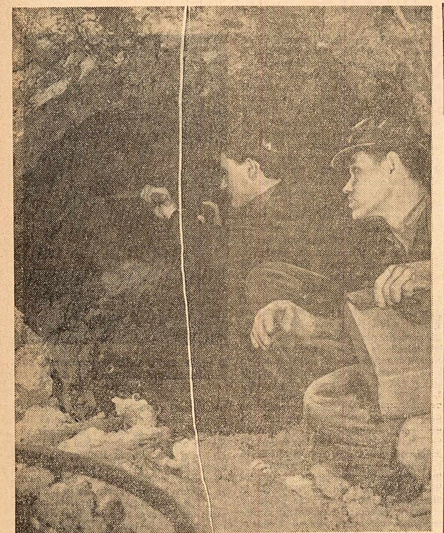
În galeriile minel Săsar, regiunea Maramureș, Artificierul Vasile Baciu și minerul Costea Emeric arînd gîurile pentru pușcare
