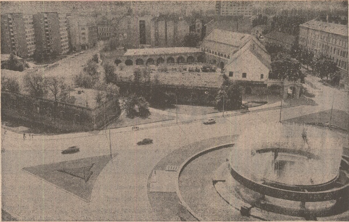
Bastionul și „roza vinturilor”
