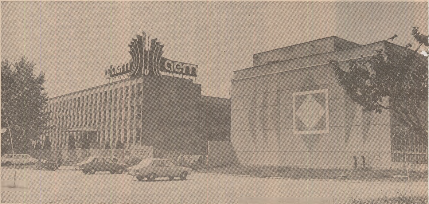
A.E.M. — Întreprinderea de aparataj electric de măsură din Timișoc
