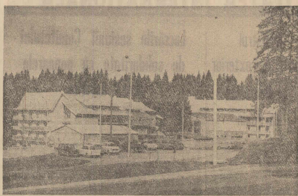
Noul hotel de lângă telefericul din Poiana-Brășov se află în stadiu de finisaj în interior și parțial în exterior. Această nouă unitate dispune de 150 camere cu 350 locuri, cu confort super, iar Restaurantul, Braseria și Barul vor putea servi circa 700 persoane. Pînă la sfîrșitul acestui an hotelul va fi dat în folosință.
