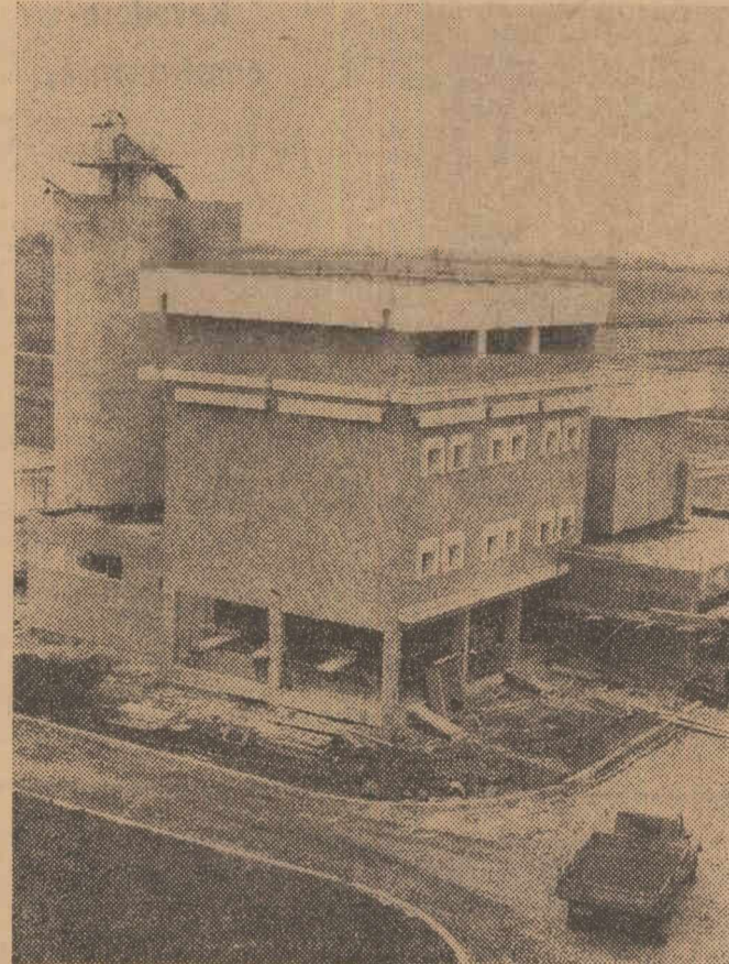
Pe șantierul Stației de tratare a apei de la Roșu, lucrările de construcții-montaj au intrat într-o nouă fază: paralel cu definitivarea construcției decantoarelor de nămol se lucrează intens la pregătirea filtrelor rapide în vederea intrării acestora în exploatare, intensificîndu-se totodată și lucrările de specialitate necesare intrării în funcțiune a stației chimice și a construcțiilor aferente. În clișeu: Aspect de pe șantier
