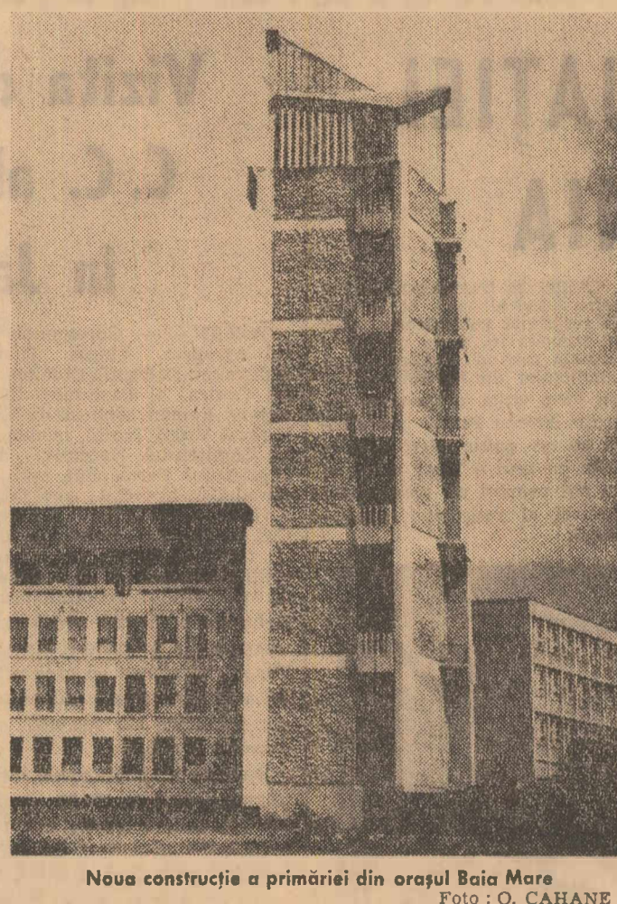
Noua construcție a primăriei din orașul Baia Mare. Foto: O. CAHANE
