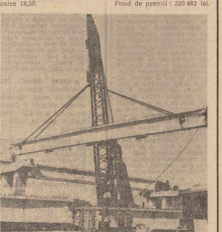
Greutățile de circulație între oraș și danele din Galați vor fi înlăturate prin construirea unui nou pasaj superior peste calea ferată ce va fi dat în circulație la sfîrșitul acestui an. Pasajul va avea o lungime de 300 m, 14 m lățime și opt descendere. În cluse: ridicarea grinzelor comprimate de 75 tone cu macarua gigant
