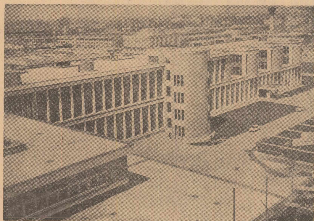
Institutul Politehnic, noua cetate universitară de pe malul Dimboviței din Capitală. Impunătorul edificiu va avea în final 281 amfiteatre, 30 săli de curs, 82 săli pentru seminarii, 584 laboratoare și alte dotări importante
