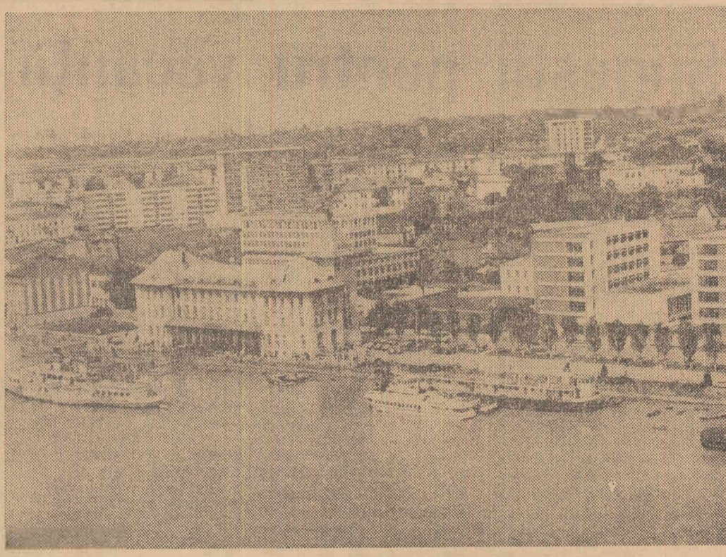
GALAȚI: Imaginea unui oraș în plină înflorire. Por tul înregistrează fidel ritmurile moderne ale cetății siderurgiei românești, în același timp șantier naval și punct de tranzit pentru oaspeții care călătoresc pe luciul apelor bătrînilui fluviu către împărăția Deltei
