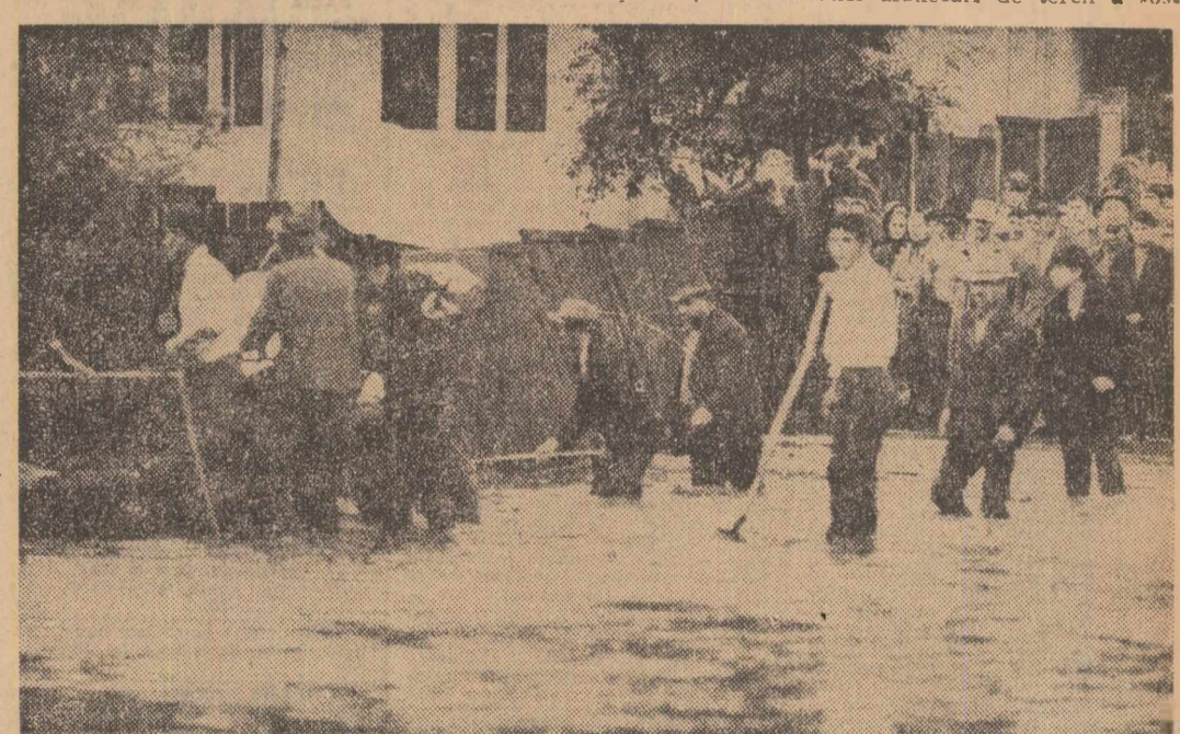
Lucrări pentru degajarea apelor în cartierul Mănuștur din Cluj
