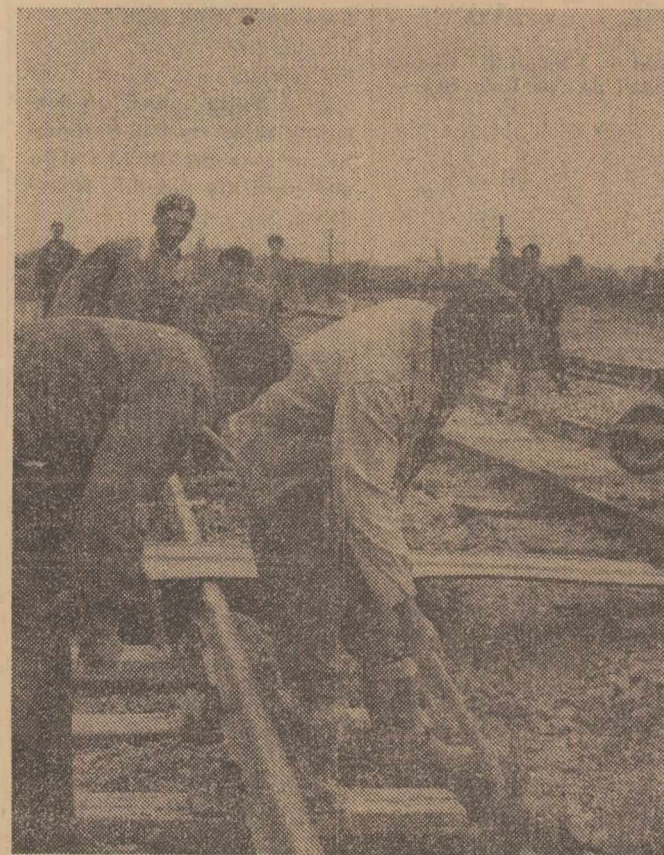
O secvență din eroica muncă de reconstrucție. Mobilizați de chemarea partidului, oamenii reconstruiesc ceea ce apele au distrus. Și în timp ce munca de refacere continuă fără răgaz — exact o lună de când inundațiile au lovit primele localități —, oamenii stăvlesc cu aceeași abnegație și neclintită voință apele dezlănțuite din nou în aceste zile ca urmare a ploilor abundente căzute în unele zone din țară.
