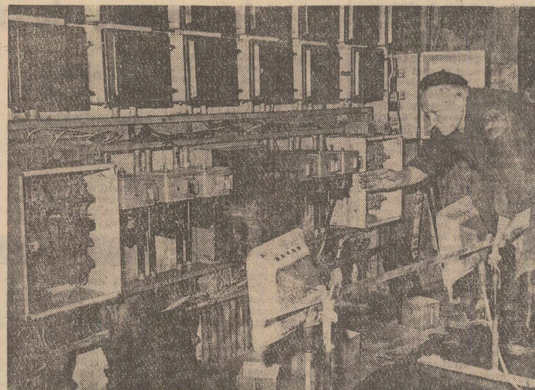
La fabrica „Tirnavă” din Mediaș sînt uscate instalațiile cu radianți cu infraroșii
