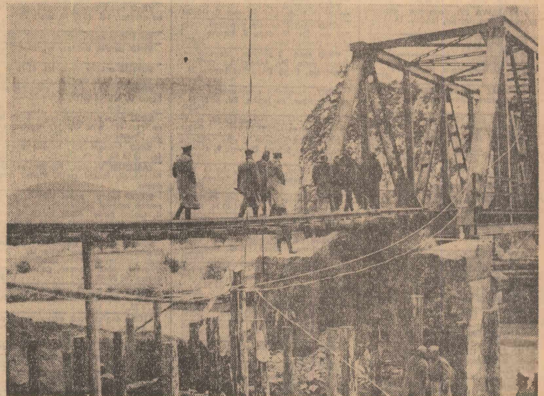
Măgheruș-Șieu. Ferovieri, constructori și ostași, într-o unică încordare, refac grabnic podul luat de ape
