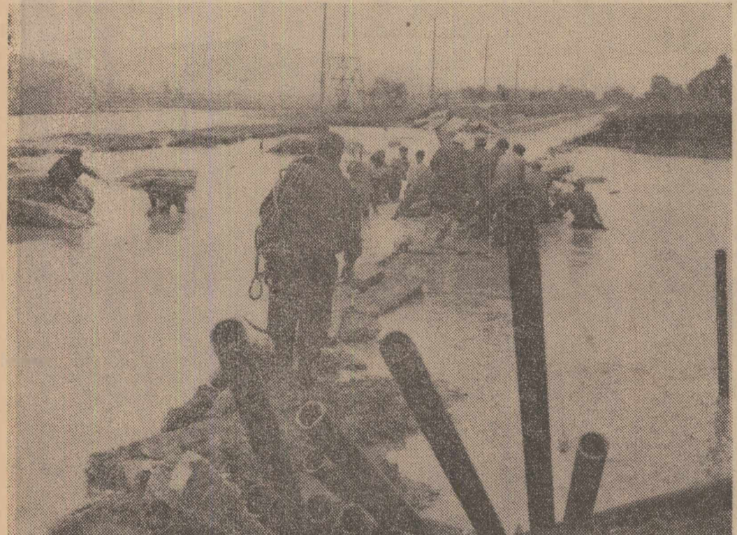
Se execută repunerea în funcțiune a instalațiilor termocentralei Singiorgiu de Pădure — Fîntinile
