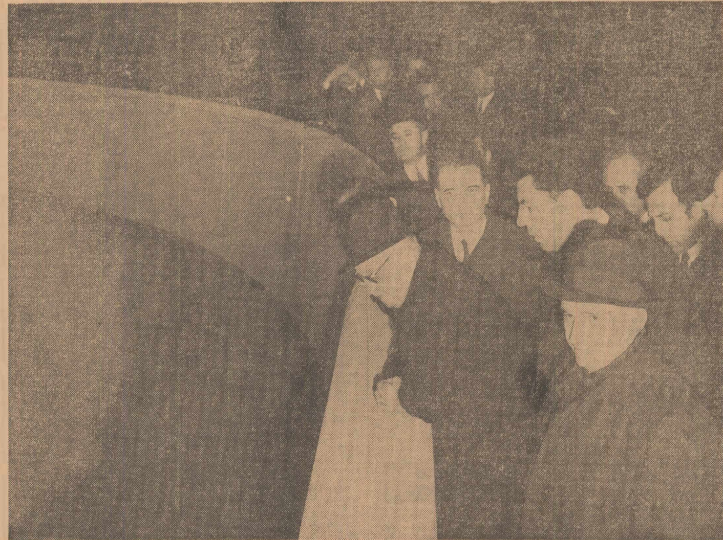
La barajul Hidrocentralei
