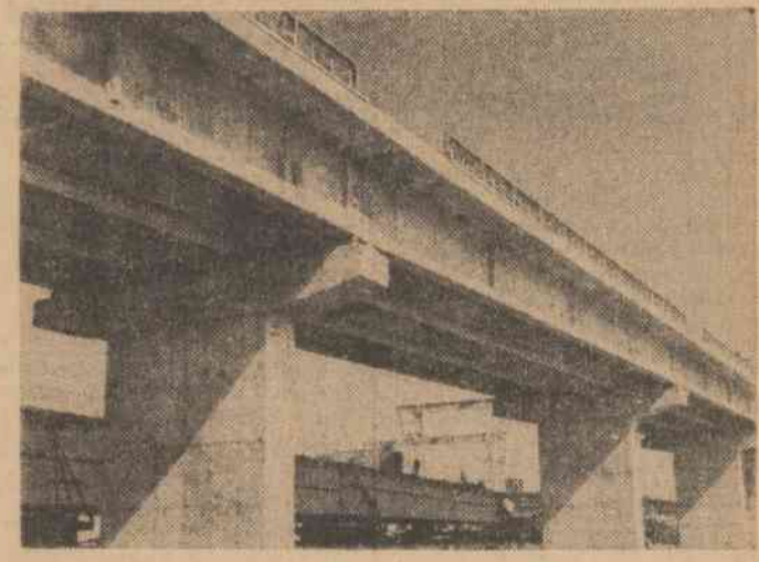
Pe santierul podului Giurgeni-Vadu Oii activitatea se desfășoară în ritm intens. S-au terminat viaductele de pe cele două maluri și se lucrează la finisarea și montarea balustradelor și la construcția tablurilor metalice. În clișeu: Aspect de pe santier
