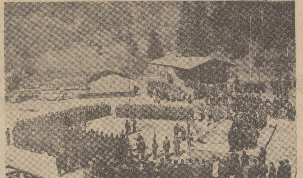
Moment solemn pe șantierul hidrocentralei de pe Lotru. În mijlocul tradiționalului coreu al brigadierilor se ridică pe catarg tricolorul românesc Foto: SANDU CRISTIAN
