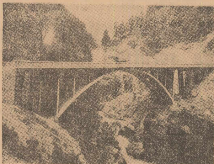
Unul din podurile nou construite în drumul spre barajul de la Lotru
