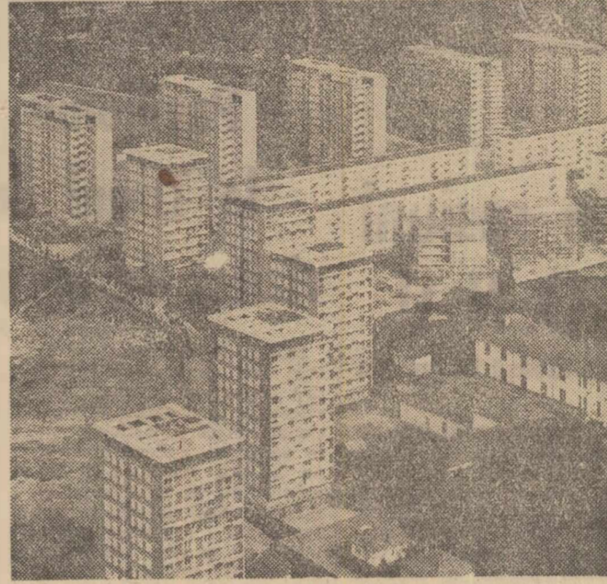
Vedere parțială a noilor construcții din cartierul Cornișa din Bacău
