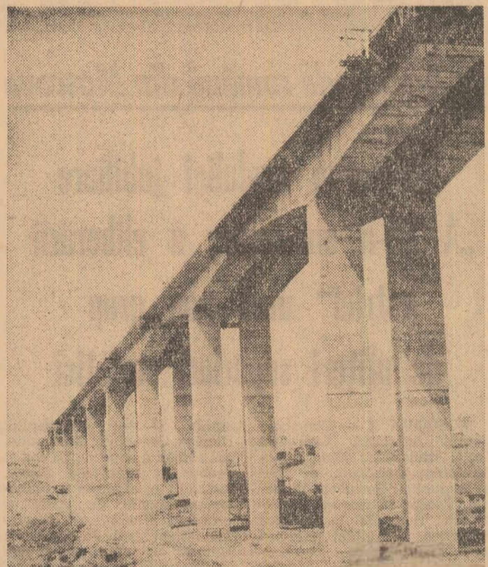
Aflat în fază de finisare, Viaductul Cățușa, pe care îl prezentăm în imagine va lega orașul Galați de marele Combinat siderurgic de pe malul Dunării.
