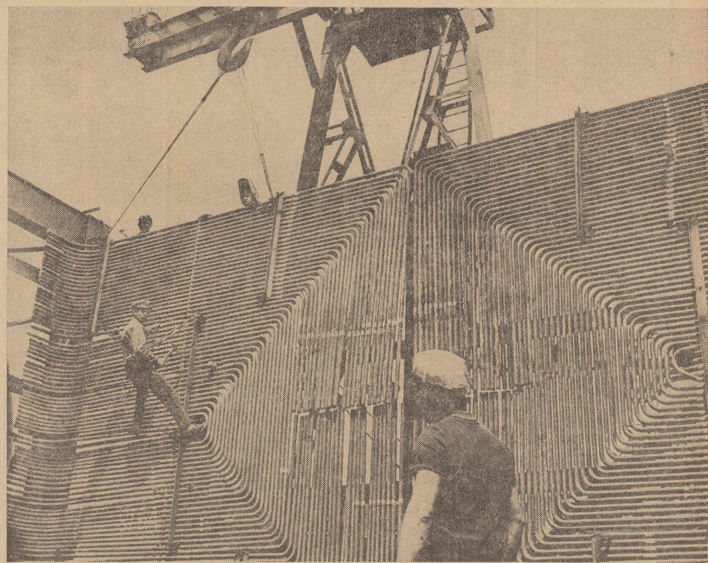
Pe șantierul uneia dintre cele mai puternice termocentrale ale țării, cea de la Deva, se lucrează în aceste zile intens în vederea punerii cit mai curînd în funcțiune a primului grup de 200 MW. Constructorii se străduiesc să îndeplinească cu cînte angajamentele în intracarea socialistă pe care le-au marcat în cinstea Congresului partidului: obținerea, pînă la sfîrșitul anului, a unei depășiri de plan în valoare de 6,5 milioane lei. În cîșeu: Aspect caracteristic de pe șantierul marii centrale electrice. Foto: NICU VASILE
